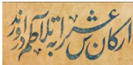
تصویر ۱۸. سوزن‌زنی نادرست در انتقال خط کتیبه بر زمینه گچ، سردر شمالی مسجد جامع اصفهان، عصر قاجار (مأخذ: نگارنده)
