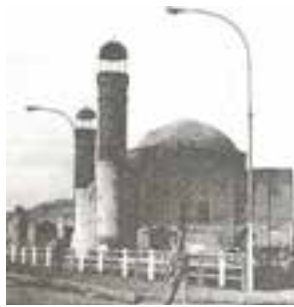
تصویر ۸: تصویری از بقعه (مسجد) صاحب الامر پس از احداث خیابان دارایی
