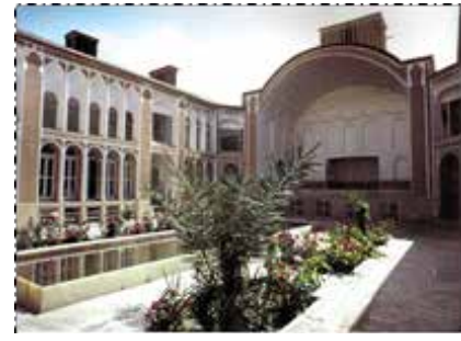
تصویر ۳. جبهه شمالی و غربی حیاط بیرونی
