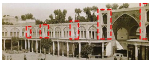
تصویر ۳. تنوع ریتم و نحوه‌ی اتصال جداره‌ی جنوبی به سردر به‌وسیله‌ی نیم‌طاق‌ها در سبزه‌میدان تهران (مأخذ: سمسار و سراییان ۱۳۸۲)
