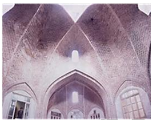
تصویر ۱۷: گنبد با باریکه طاق‌های باربر مقطع از تیمچه حاج شیخ کاظم بازار تبریز. (حاجی قاسمی، ۱۳۲، ۱۳۷۵). و نمای زیر گنبد تیمچه حاج شیخ کاظم. (حاجی قاسمی، ۱۳۲، ۱۳۷۵).
