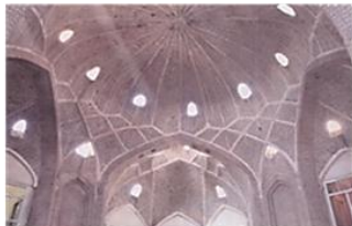
تصویر ۱۶: گنبد با باریکه طاق‌های باربر تیمچه ملک در بازار تبریز. (حاجی قاسمی، ۱۳۹، ۱۳۷۵). و نمای زیر گنبد تیمچه ملک. (حاجی قاسمی، ۱۳۷، ۱۳۷۵).
