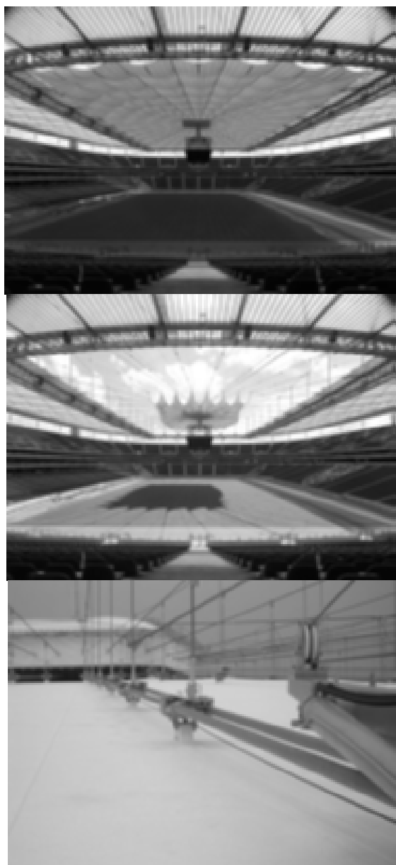
شکل (1): سقف باز و بسته شونده استادیوم کامرزبانک و مکانیزم مکانیکی متحرک آن [۴].
