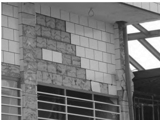
شکل ۶) فروریختن سنگ‌های پلاک به دلیل عدم استفاده از پیچ و رول‌پلاک یا اسکوپ [25]
