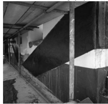
شکل ۲) مقاوم سازی با استفاده از الیاف [23]
