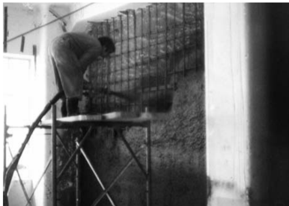
شکل ۱) مقاوم‌سازی با فناوری شاتکریت [23]
