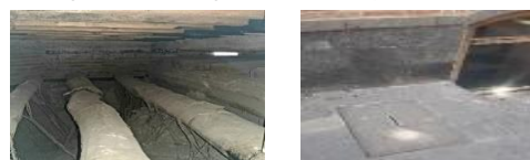
تصاویر کانال‌های هوایی پی و سقف دو لایه شاه‌نشین خانه ابراهیمی
