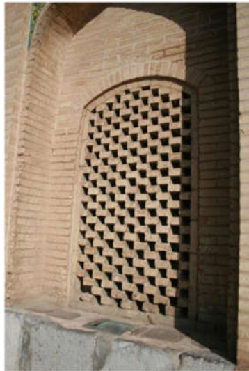
تصویر شماره ۱: انواع آجرچینی دیوارها جهت معنابخشی در ابنیه
