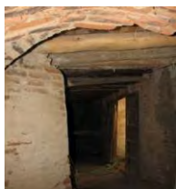
شکل ۱۷. زیرزمین غربی خانه بیرونی
