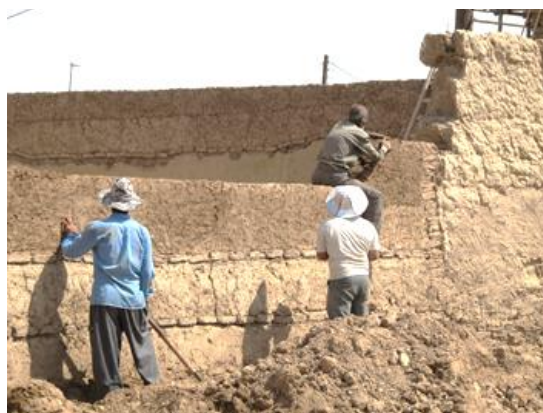
تصویر ۷- اجرای چینه، حصار شهر تاریخی بشرویه، خراسان جنوبی
