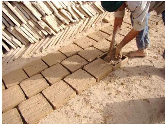
تصویر ۶- تولید خشت در کارگاه مسجد جامع میبد، یزد مأخذ: (نگارندگان - تابستان ۸۸)
