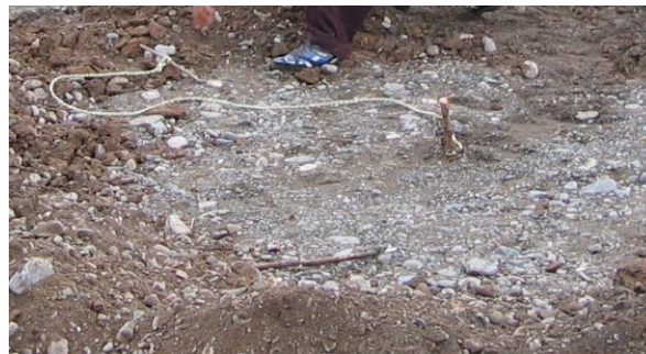
تصویر ۲۲- میله و طناب برای پیاده کردن نقشه کپر بر روی زمین، (مأخذ: علی‌دادی سلیمانی، ۱۳۹۵).
