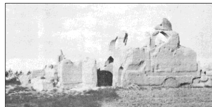
تصویر ۱۳- نمای جنوبی مسجد جامع هفتشویه از پشت گنبدخانه (سیرو، ۱۳۵۷).
