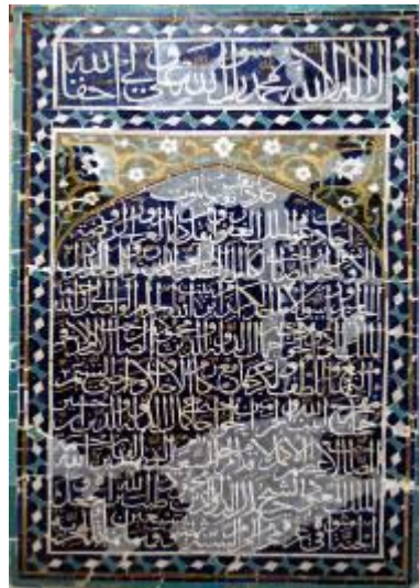
تصویر ۵: نمایی از کتیبه مرمت شده مسجد ریگ مجومرد یزد (ماخذ: آرشیو پایگاه میراث فرهنگی شهر تاریخی یزد)
