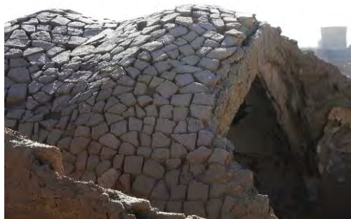
تصویر ۶: سقف قسمتی از خانه سیگاری‌های یزد که با دورریختنی‌های آجر آب انباری پوشیده شده است. (ماخذ: ادب، ۱۳۸۹)
