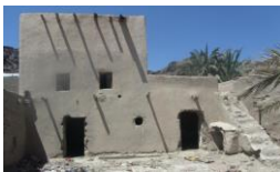
عکس ۵: بادگیر (اتاق ساخته شده در طبقه بالا) جهت تطبیق با شرایط اقلیمی
