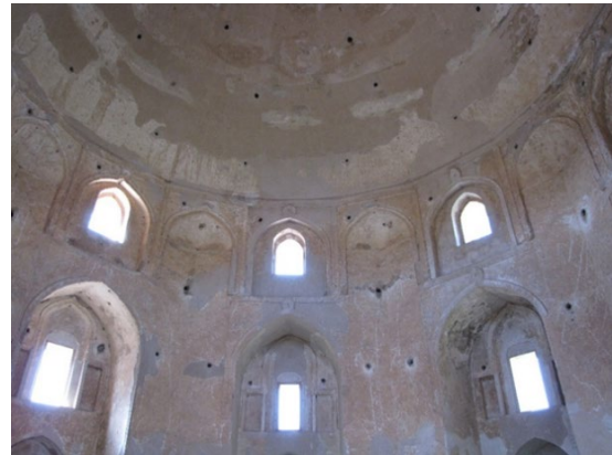
شکل ۹. نمای داخلی و تقسیمات منطقه انتقال گنبد بنا منبع: نگارنده، ۲۰۱۵
