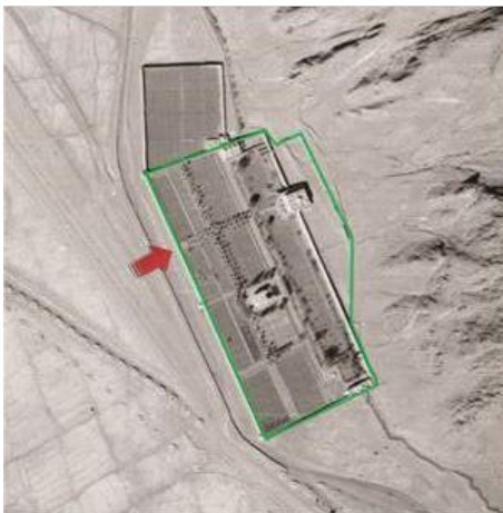
شکل ۴. وضعیت اولیه دیوارکشی و ورودی باغ بیرم‌آباد در دوره اولیه ساخت
