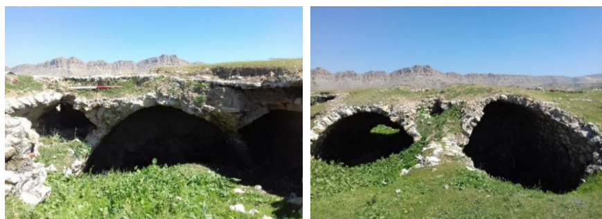
تصویر ۸. نمونه‌های از تاق‌های آهنگ با چفد هلوچین کند زاغه (نگارندگان، ۱۳۹۹). ◀
