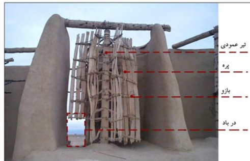
شکل ۶. تیر عمودی، پره، بازو و درباد در آسیاد
