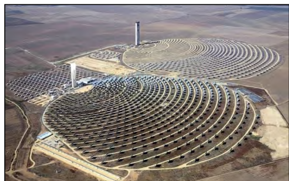
شکل 36: نیروگاه‌های برج خورشیدی PS10 (جلو) و PS20 (عقب) به ظرفیت 11 و 20 مگاوات در اسپانیا [50]
