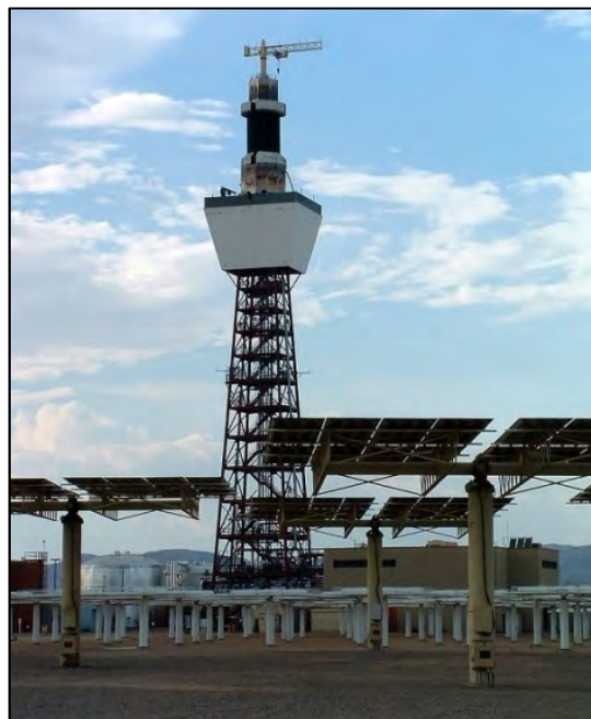
شکل 15: برج و هلیواستات‌های مورد استفاده در نیروگاه‌های سولار 1 و 2
