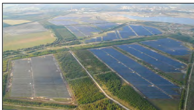
شکل 30: نیروگاه 166 مگاواتی موبرو در آلمان
