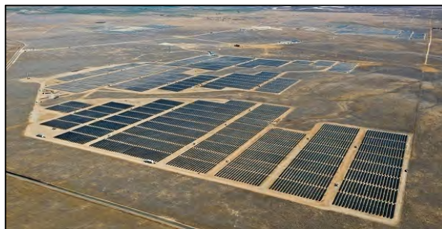
شکل 27: نیروگاه 250 مگاواتی کالیفرنیا در آمریکا
