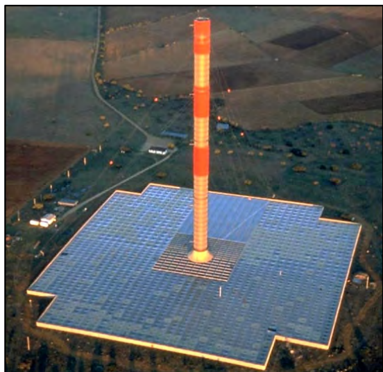
شکل 22: نمونه آزمایشی تنوره خورشیدی در اسپانیا
