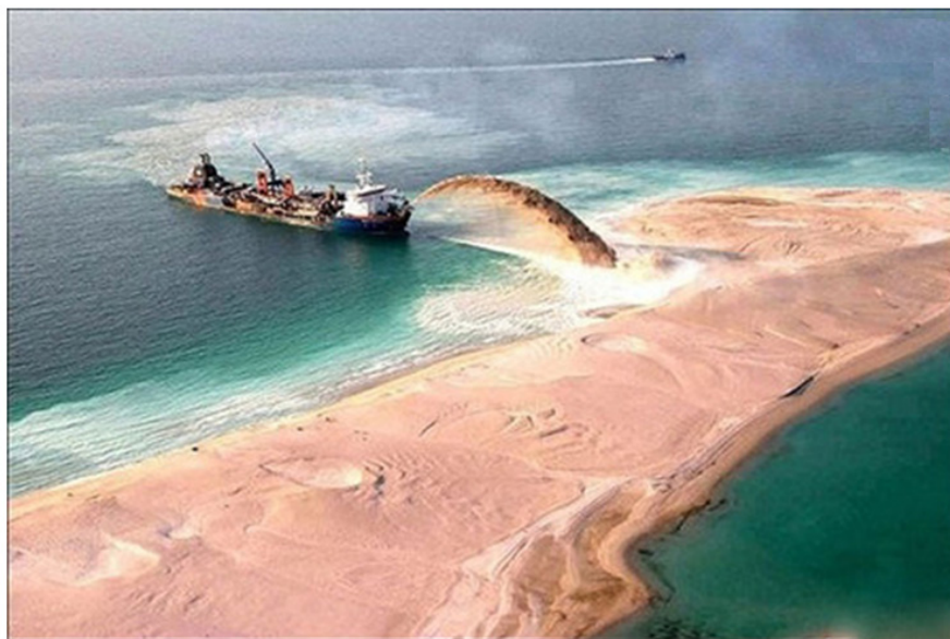
(شکل ۲): فرایند احداث جزایر مصنوعی
