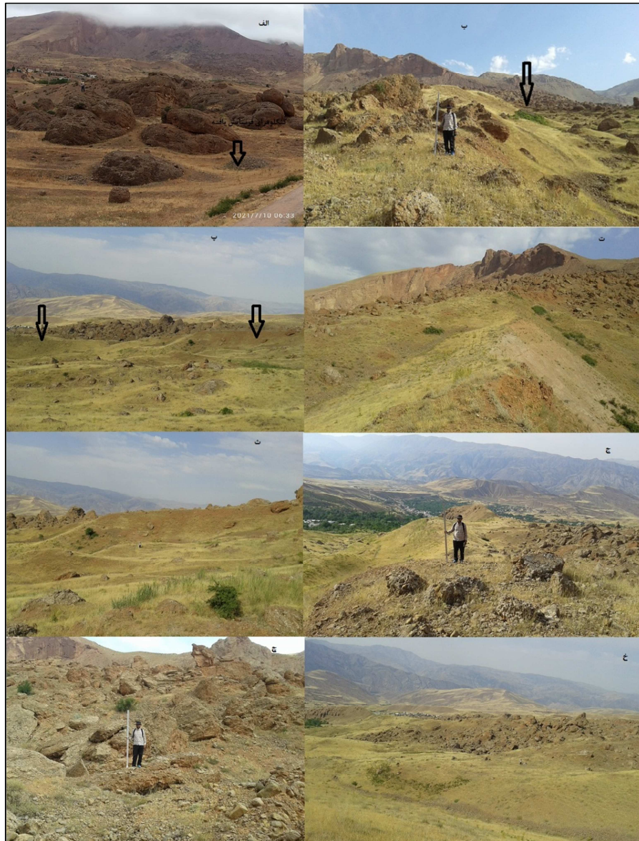
شکل ۴: توده‌های کنگلومرایبی و نمونه تجزیه‌شده آن (الف). چشمه‌های ناشی از زمین لغزش (ب). سدهای لغزشی عمود بر زمین لغزش (پ). بخش‌هایی از گستره زمین لغزش در قسمت شرقی (ت و ث). مرز بین زمین لغزش کنگلومرایبی و مارنی موازی با زمین لغزش (ج). زمین لغزش صفحه‌ای (چ). سد سولی فولکسیونی زمین لغزش
