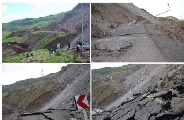
شکل ۱: نمایی از زمین لغزش رخ داده در جاده نیر- سراب (گردنه صائین) که در آن تند شیب مشرف بر جاده و سنگ‌های خردشده بالادست لغزش، نمایان است (مأخذ: سایت‌های داخلی).
