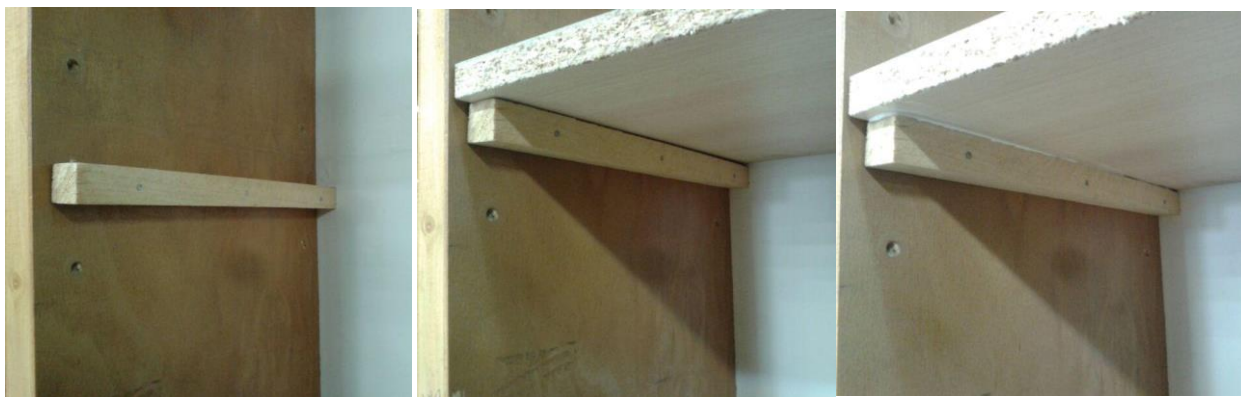
شکل ۱- زیر سری، طبقه زیر سری و طبقه چسبیده شده. به ترتیب از چپ به راست: زیر سری، طبقه با اتصال جدانشدنی و طبقه با اتصال ثابت
