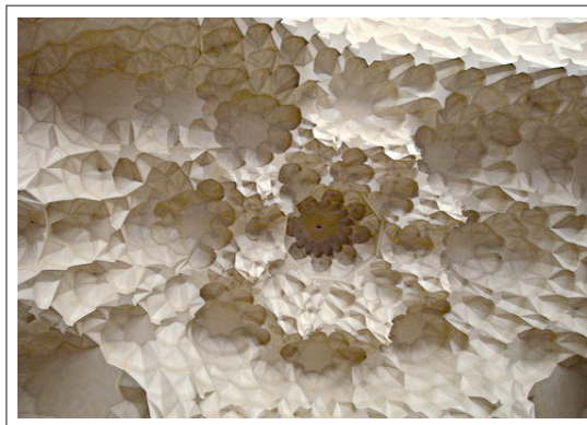
تصویر ۲۳: بخشی از کاربردی یکی از سقف های خانه شیخ الاسلام.
