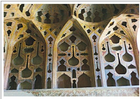
تصویر ۱۴: لایه‌چینی بر روی تنگ‌بری دیوار عالی‌قاپو، منبع: نگارندگان.
