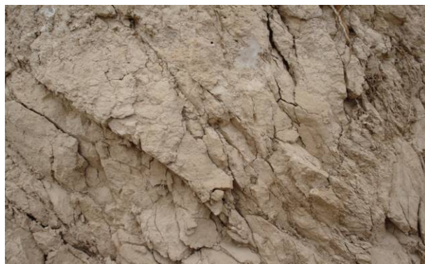
تصویر ۱۶- ترک‌های کششی در لس‌های ناحیه ۱
