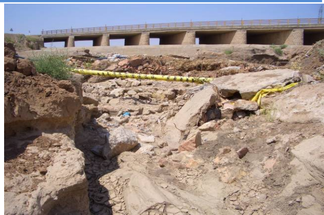
تصویر ۹- تخریب تاسیسات در اثر برداشت بی‌رویه مصالح از رودخانه - زمستان ۱۳۸۹
