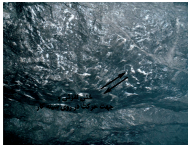
تصویر ۶- اثر خطوط لغزش در توده سنگ سینه کار و دیواره تونل
