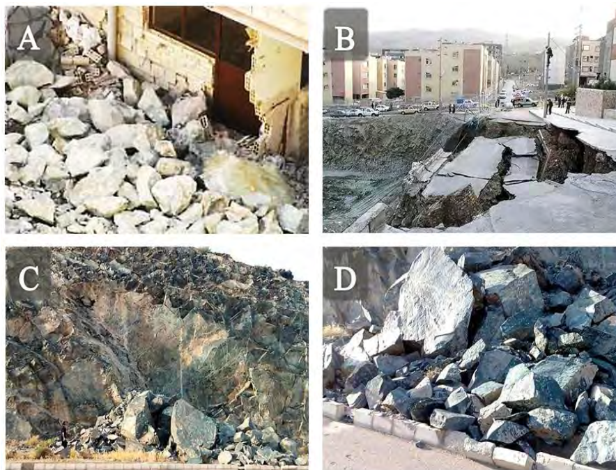
شکل ۱۳. مشکلات مربوط به سنگ‌های اولترامافیک منطقه، A: ناپایداری دامنه، B: ریزش گود، C و D: لغزش سنگ‌ها (جنوب غرب مشهد)
