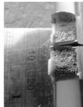
شکل ۹ ب- جزئیات سطح شکست نمونه استخراج شده از درز جوش
