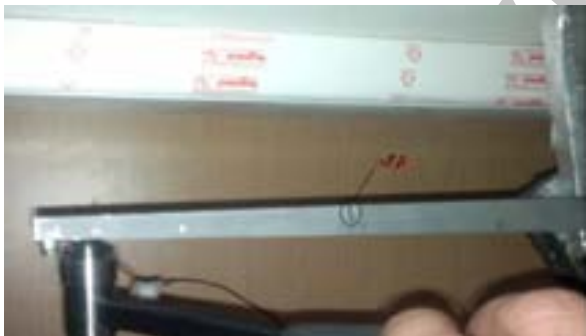
شکل ۳ تیر ترک‌دار با سطح مقطع متغیر
