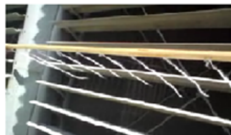
شکل ۱۱ الگوی جریان هوا در محل ۱ دلتای مناسب
