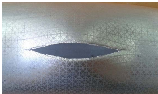
شکل ۱۰ دایره‌های حک شده بر روی لوله
