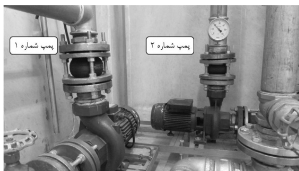
شکل ۷ پمپ‌های شماره ۱ و ۲ آزمایشگاه جریان چندفازی دانشگاه تربیت مدرس
