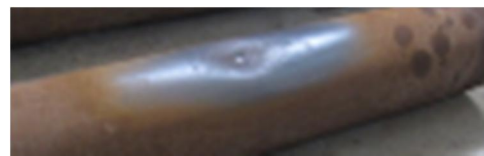
شکل 1 نمونه ای از فرورفتگی در لوله
