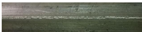
Fig. 24 Cracks appearing from sharp points in the final form شکل 24 ترک خوردن از محل نوک‌تیز در شکل نهایی
