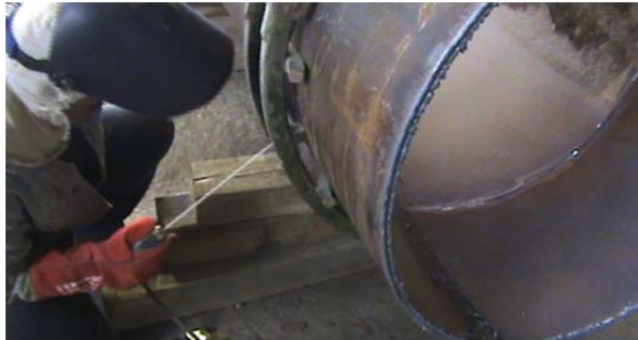
شکل ۱) جوشکاری سربه‌سر لوله
