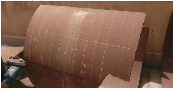
شکل ۴) خطکشی و برش اولیه لوله
