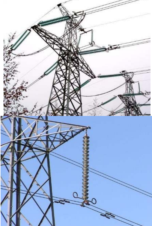
شکل ۱) مقره‌های مورد استفاده در خطوط انتقال برق؛ (راست) مقره انتهایی بسته (کششی)، (چپ) مقره معلق
