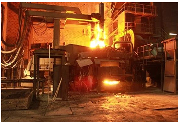
شکل ۱) کوره قوس الکتریکی مجتمع صنعتی فولاد اسفراین
