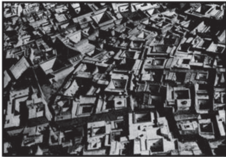
تصویر شماره ۲: محله‌ای در مراکش که در آن نحوه انتظام خانه‌ها در کنار معابر قابل مشاهده است (حکیم ۱۳۸۱: ۵۸).
