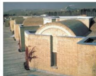
تصویر شماره ۳۵: ایجاد ریتم به وسیله تکرار یک، عدول، سده‌خانه از قوس‌ها حرکت عمودی چشم را سبب می‌شود نحوه استقرار مدول‌ها سایه‌اندازی ایجاد می‌کنند (منبع: www.archnet.com )
