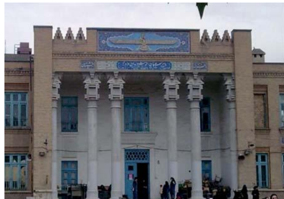
تصویر شماره ۱۹: مدرسه انوشیروان دادگر (۱۳۱۵-۱۳۰۹ ه.ش) توسط مهندس مارکف طراحی شد. استفاده از ایوان ورودی، ستونها و سرستون‌ها، کنگره‌های بام و نقش فروهر با تقلید مستقیم از بناهای هخامنشی (منبع: ویکی پدیا)
