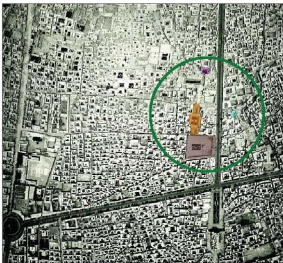
تصویر شماره ۳: عکس هوایی سال ۱۳۳۵، همجواری مهمترین مدارس علمیه در بافت تاریخی یزد که شامل مدارس: مصلا، خان، شفیعیه و عبدالرحیم خان می‌باشد. (منبع: مرکز اسناد سازمان میراث فرهنگی)
