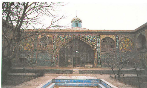
تصویر شماره ۶: حیاط و جبهه جنوبی، در ضلع جنوبی مهتابی وجود دارد که به اندازه یک متر از سطح حیاط بالاتر است و شبستان مسجد نیز در این جبهه قرار گرفته است. مأخذ: حاجی قاسمی، ۱۳۷۸: ۱۴۹
