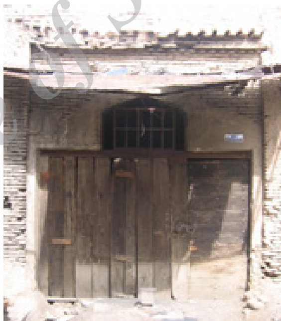
تصویر شماره ۸: نمای بیرونی حجره مسقف با تاق اسلامی. جبهه رو به بازار کامل باز می‌شود. روزن بالای ورودی، با جزئیات اسلامی به منظور تسهیل جریان هوا اجرا شده است.
