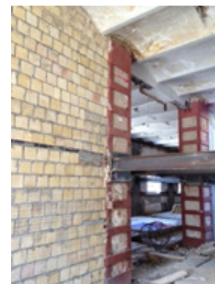
تصویر شماره ۹: بهسازی ساختمان کتابخانه دانشگاه هنر اسلامی تبریز، تقویت ستون‌های آجری موجود با استفاده از عناصر فلزی و الحاق عناصر بتنی متناسب با ظرفیت مجموعه، مأخذ: آرشیو شخصی نگارندگان
