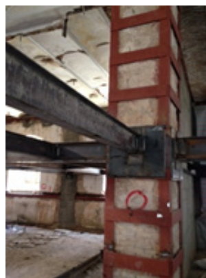
تصویر شماره ۹: بهسازی ساختمان کتابخانه دانشگاه هنر اسلامی تبریز، تقویت ستون‌های آجری موجود با استفاده از عناصر فلزی و الحاق عناصر بتنی متناسب با ظرفیت مجموعه، مأخذ: آرشیو شخصی نگارندگان
